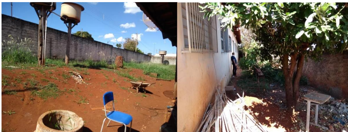
Imagem 1 - Aspectos da Escola Estadual Washington Barros França antes da intervenção
